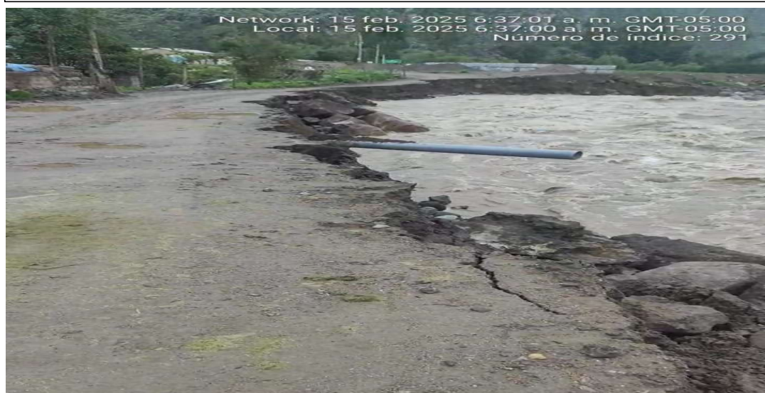
ILUSTRACION N° 3. TRAMOS N°6 AL 14 SE EVIDENCIA LA DESTRUCCION DE LAS DEFENSAS RIBEREÑAS A CONSECUENCIA DEL INCREMENTO DEL CAUDAL DEL RIO COTAHUASI
