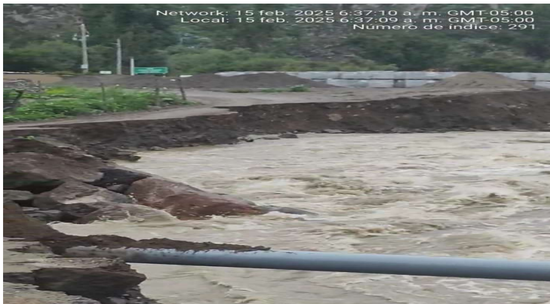
FIGILUSTRACION N° 2. TRAMOS 8,9,10,11,13,14,SE EVIDENCIA LA DESTRUCCION DE LAS DEFENSAS RIBEREÑAS A CONSECUENCIA DEL INCREMENTO DEL CAUDAL DEL RIO COTAHUASI
